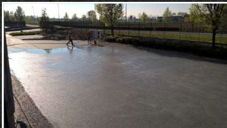
Intasamento dell'asfalto con la malta cementizia
