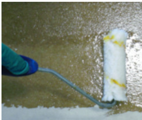
Applicazione di Mapefloor I 910 come promotore di adesione
