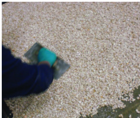
Applicazione della miscela di Mapefloor I 910 e aggregati naturali
