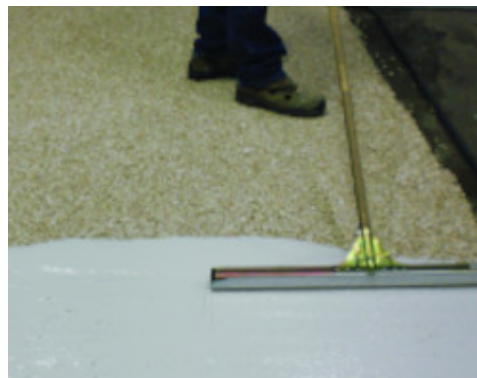
Stesura di Ultratop sulla superficie indurita di Mapefloor I 910 e aggregati naturali
