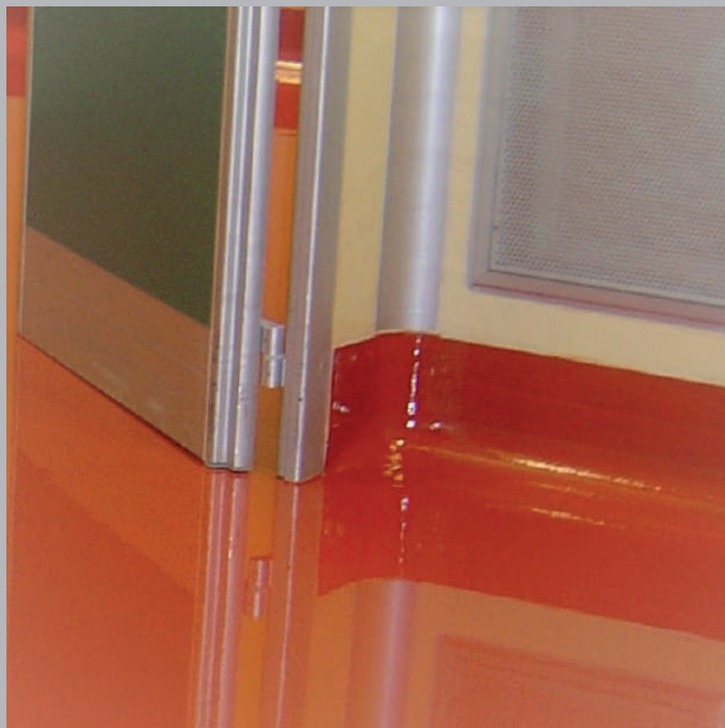
Sguscia di raccordo tra pavimento e parete
